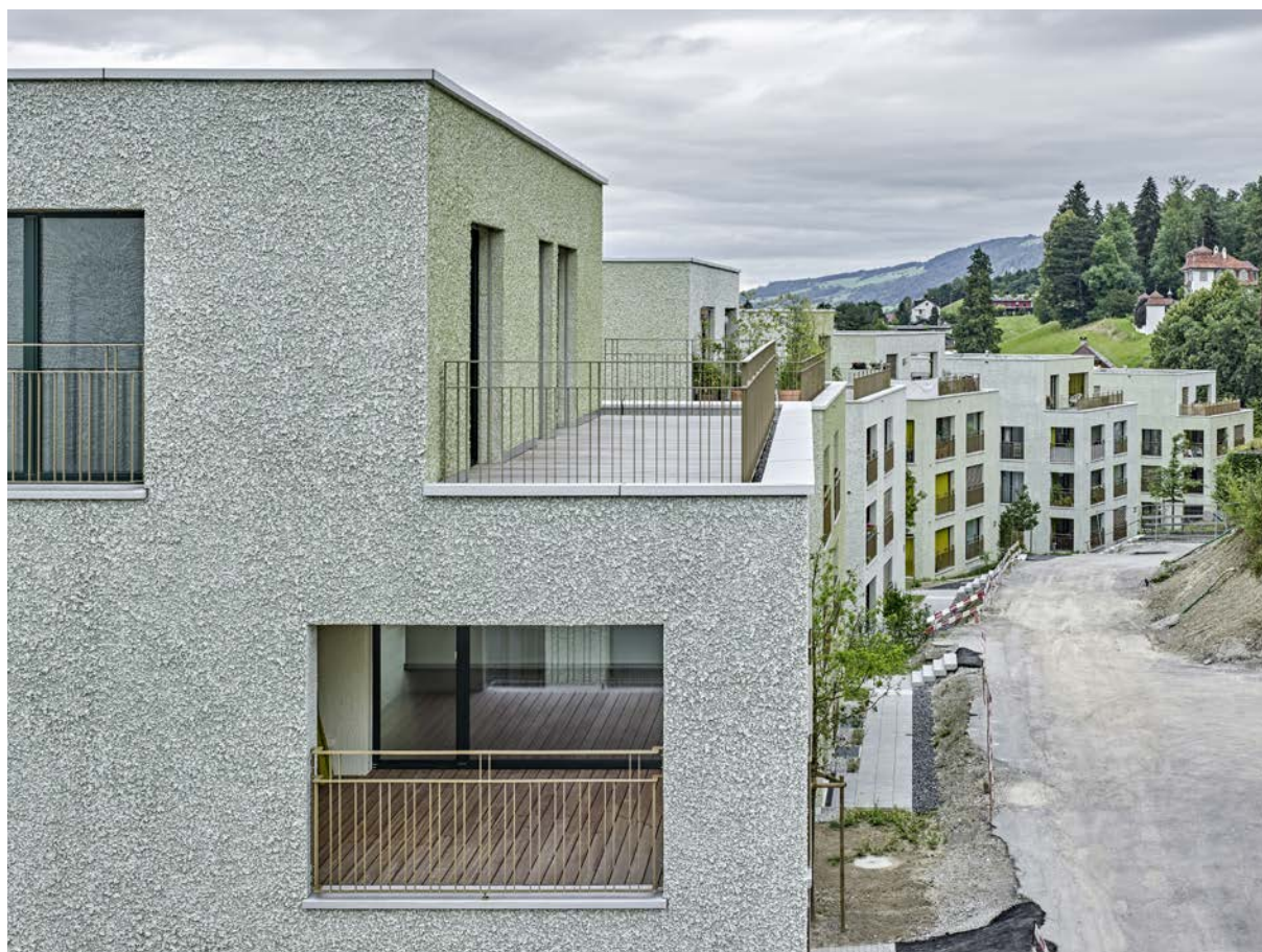
Gesamtübersicht der Erweiterungsbauten
