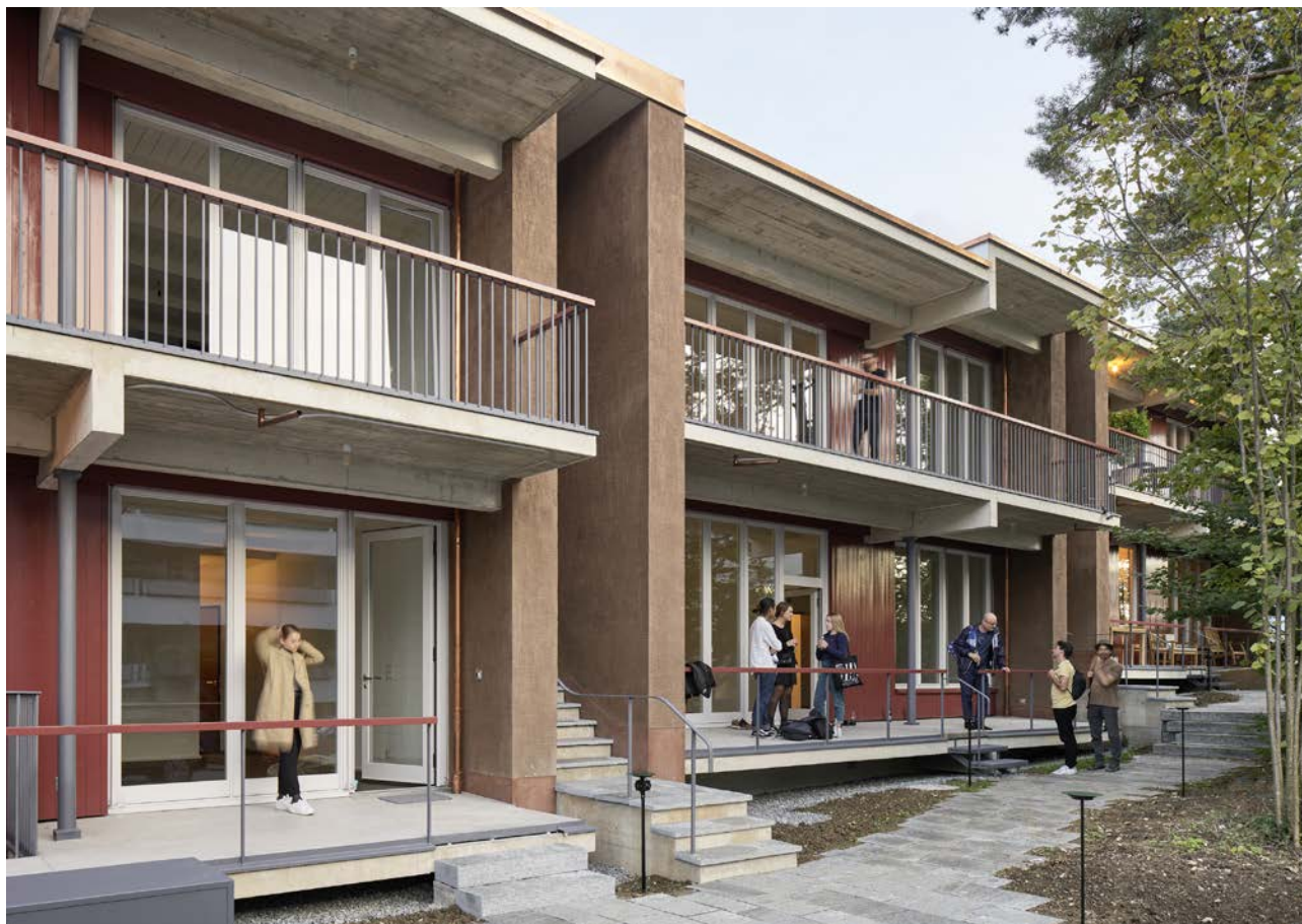
Eingangsseite mit verputzten Mauerstirnen, die an die Baumrinde der Kiefer erinnern
