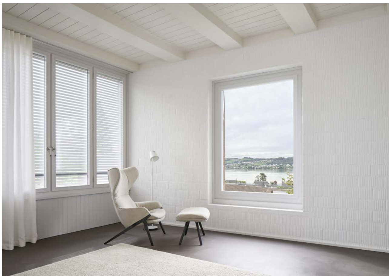
Wohnzimmer im Obergeschoss mit geschlämmten Wänden und in Ölfarbe gestrichener Decke
