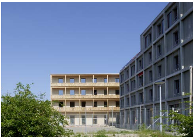
Die Hofseite im Südwesten mit ihren vorgelagerten Holzbalkonen Bild: Barbara Bühler
